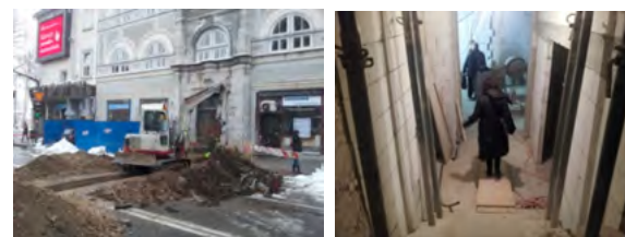
Gradbena dela so se začela zunaj šole in nadaljevala v kleti
